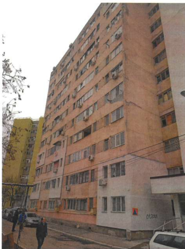
Figura 1 – Fațada principală SUD-EST.
