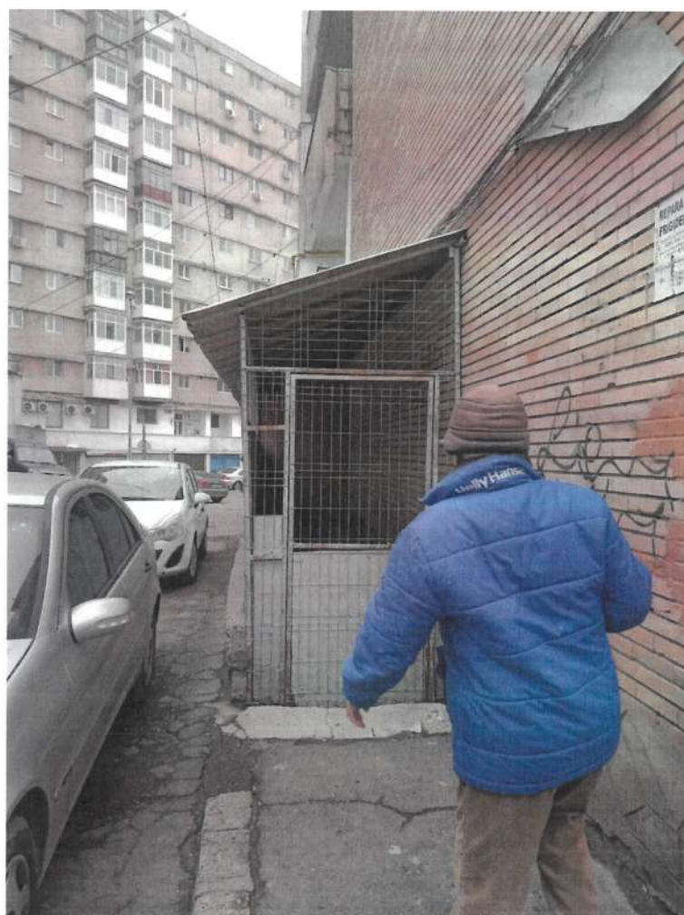
F6. Zona de acces subsol
