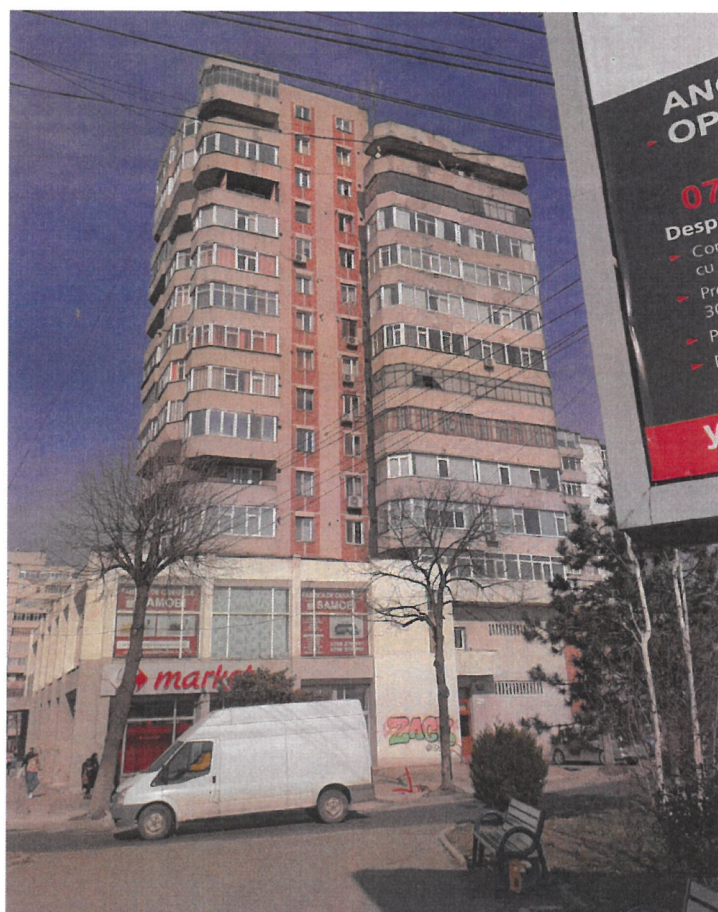
Figura 1 – Fațada principală SUD-VEST.
