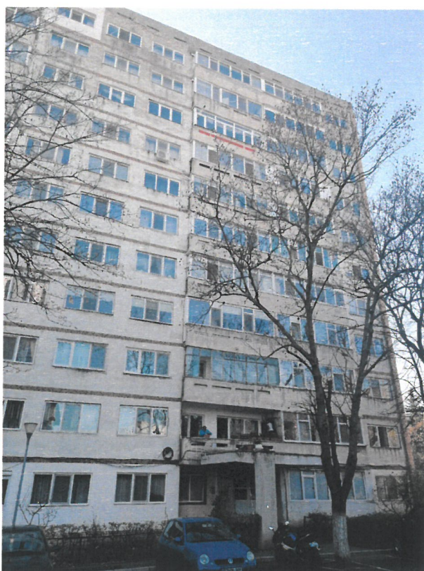
Figura 1 – Fațada principală Scara A NORD-EST.
