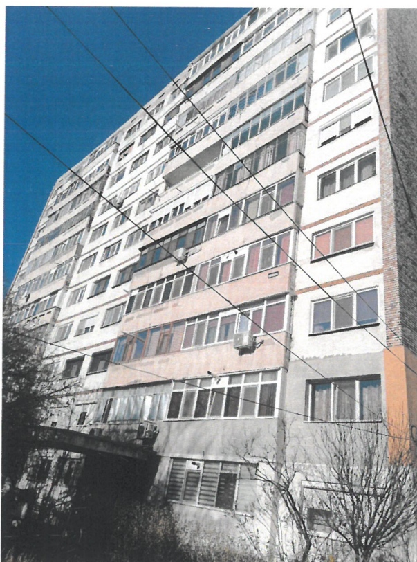
Figura 2 – Fațada principală Scara B SUD-VEST.
