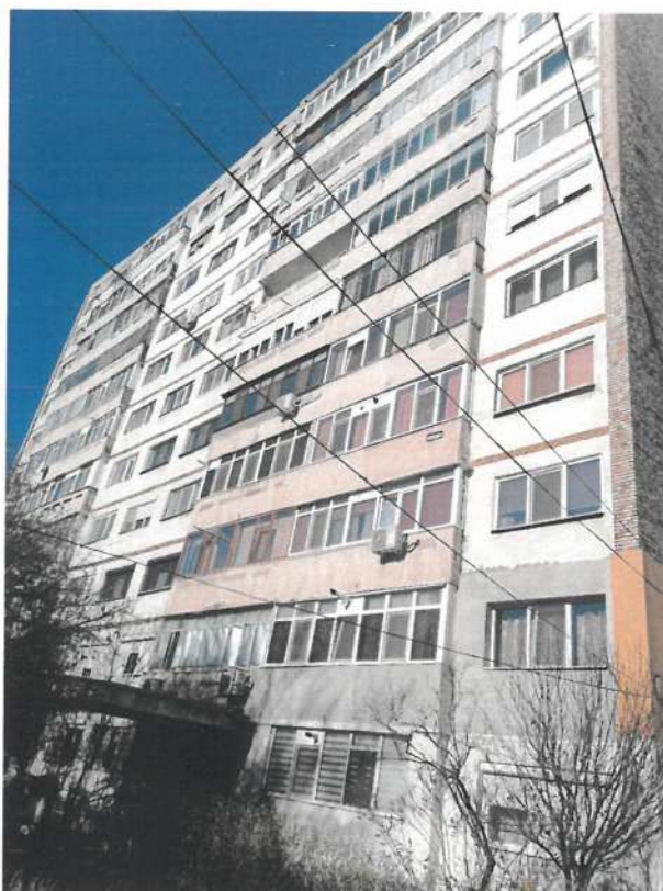
Figura 2 – Fațada principală Scara B SUD-VEST.
