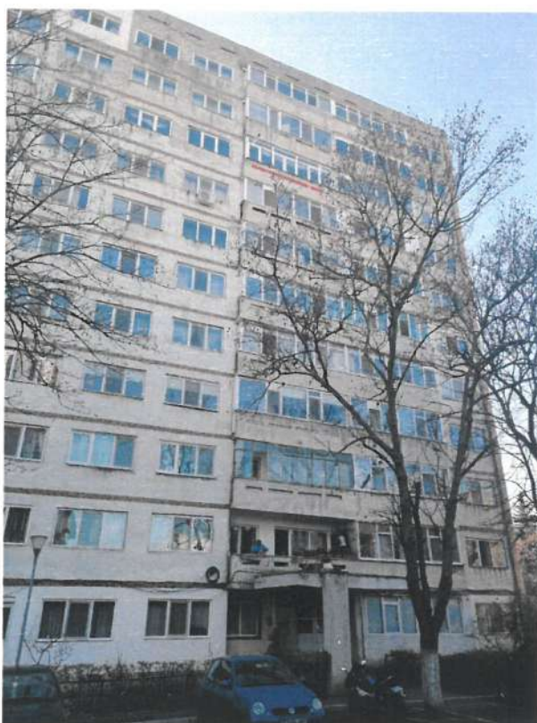
Figura 1 – Fațada principală Scara A NORD-EST.
