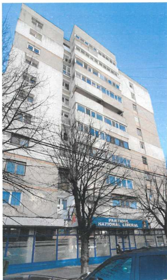
Figura 1 – Fațada principală NORD-VEST.
